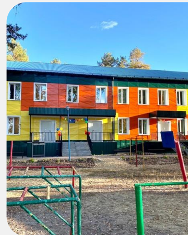
Капитальный ремонт МБДОУ «Зубово- Полянский детский сад №3 "Ручеек" в рамках реализации национального проекта "Семья"
