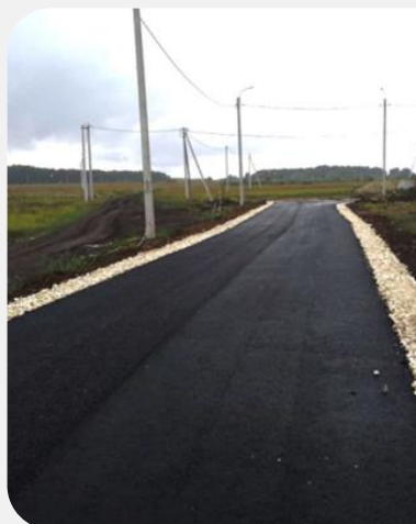
Строительство автомобильной дороги по ул. Г.Я. Меркушкина в г. Инсар
