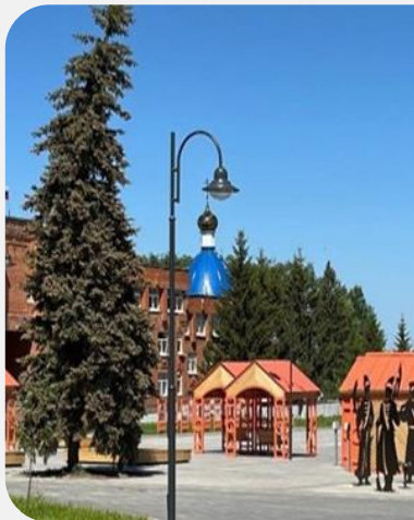
Благоустройство центральной площади по улице Гагарина в г. Инсар
